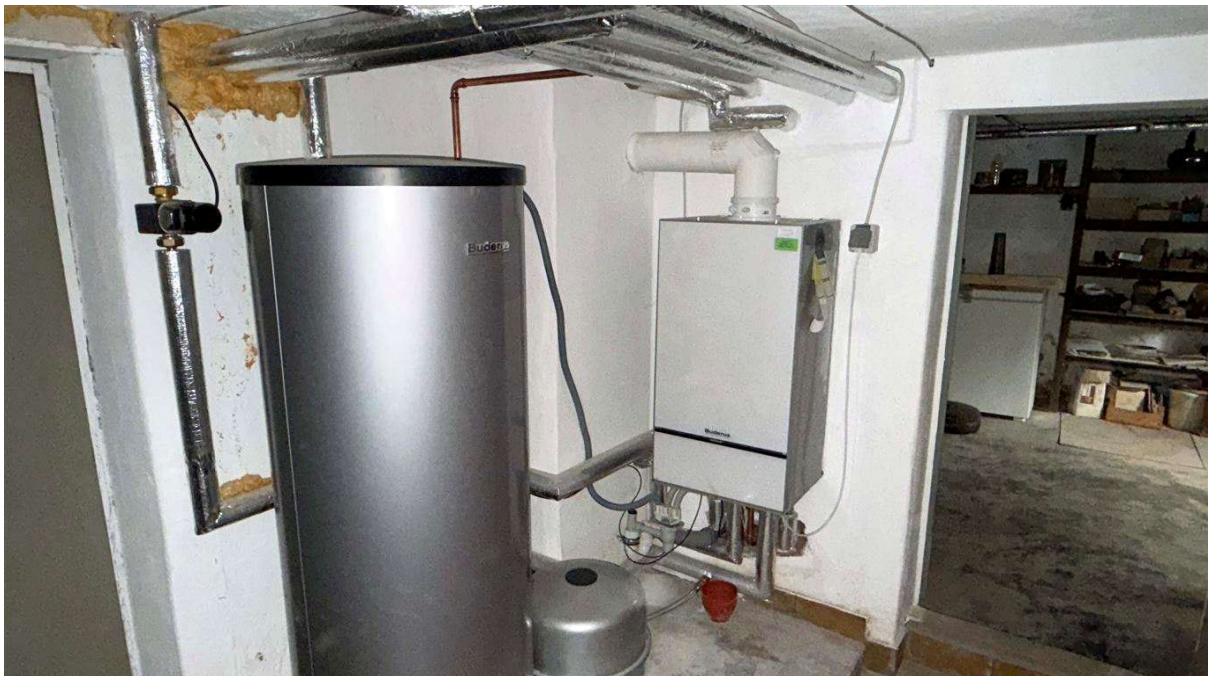
2018 neu: Erdgas-Brennwert-Heizung
